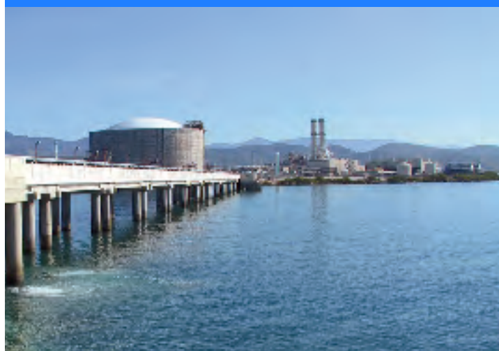
EcoEléctrica, Puerto Rico
